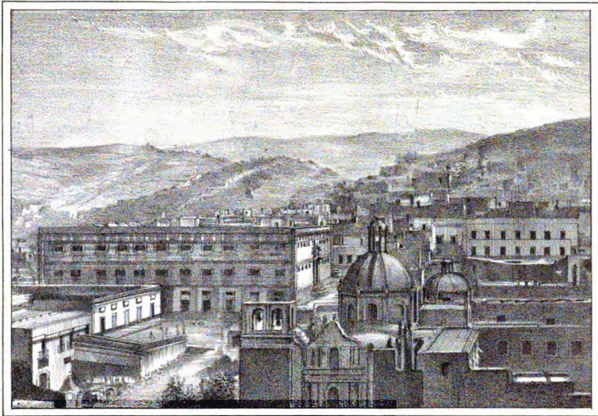
VISTA DE LA ALHONDIGA DE GRANADITAS EN GUANAJUATO. Tomada por el lado del Sur, que es la parte posterior del edificio que mira á la calle de Belen.
